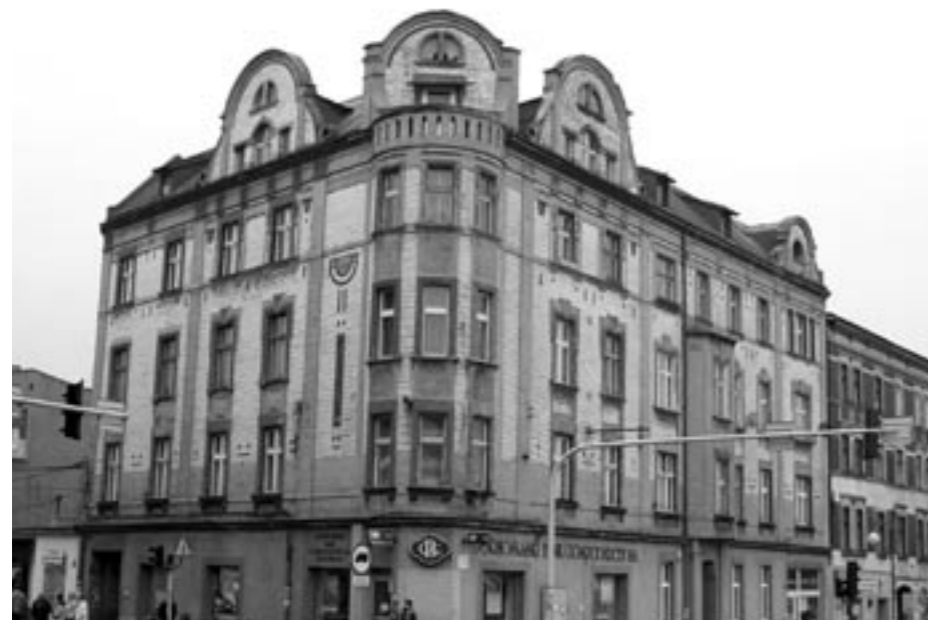
Gruntownie wyremontowany zostanie budynek przy ul. Bytomskiej 72.
